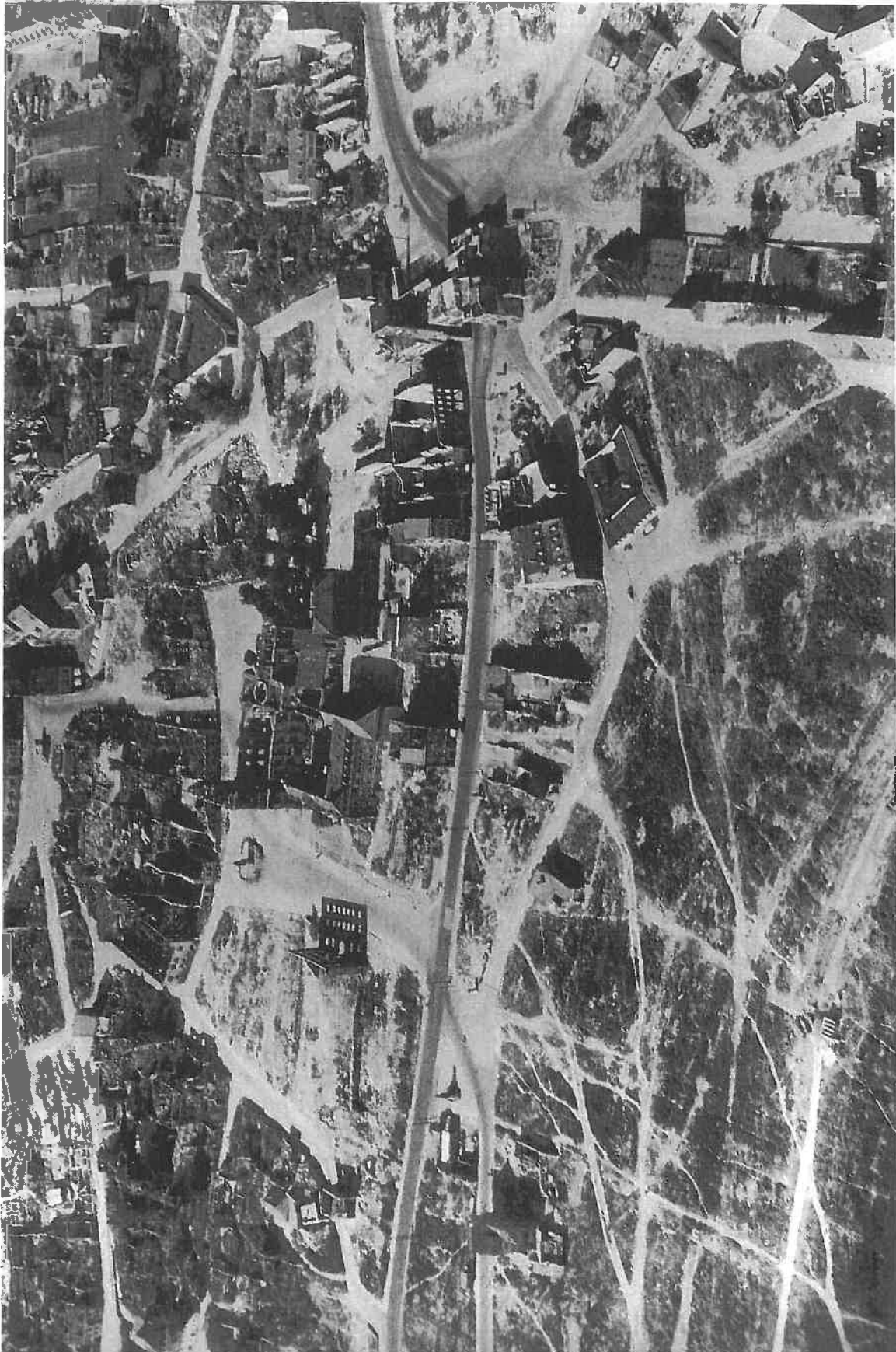
Einen Eindruck davon, wie zerstört und ausgeräumt die östliche Sebalder Altstadt in den auf den vorangegangenen Bildern vorgestellten Bereichen sechs Jahre nach Kriegsende immer noch aussah, vermittelt diese Luftaufnahme aus dem Jahr 1951 über den Egidienberg, der an den Außenmauern der immer noch ohne Gewölbe und Dach dastehenden Resten der Egidienkirche zu erkennen ist. Von der Bebauung der Westseite existiert nur noch die Fassade des Tucherpalais. Klar zu erkennen ist die West-Ost-Richtung der bis zur Ruine des Laufer Schlagturms verlaufenden Theresienstraße mit der abzweigenden Bindergasse. Unterhalb des Schlagturms nach dem unversehrten Bunker ganz unten gut erkennbar ist der zum Herrenschießhaus verlaufende Graben der zweiten Stadtumwallung. Auf der riesigen Fläche südlich der Theresienstraße haben sich schon die Pionierpflanzen zur, nur von Trampelpfaden durchbrochenen „Steppe“ breitgemacht.
